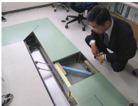
免震床の内部を覗き込む濱地会長
