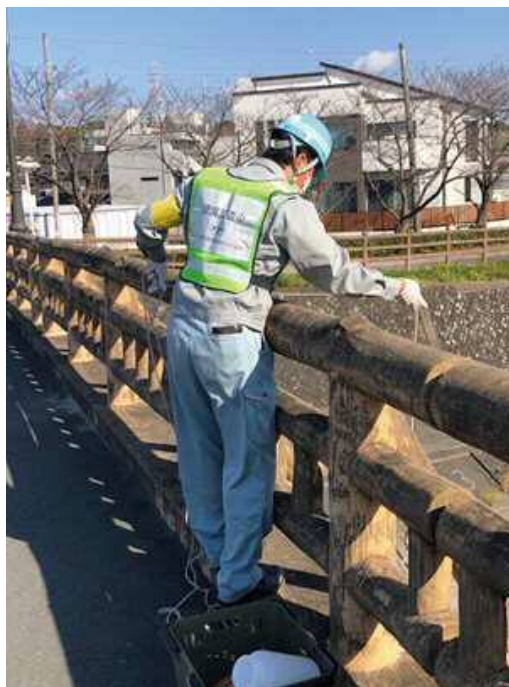
訓練実施状況(豊橋市:下立合橋)
